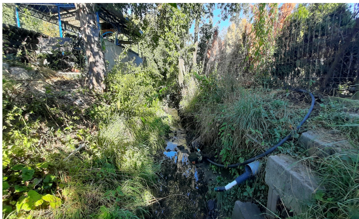
Fot.6. Widok rowu na wysokości działek nr 814 i 815 (ul. Niecała nr 6 i ul. Niecała 8).
