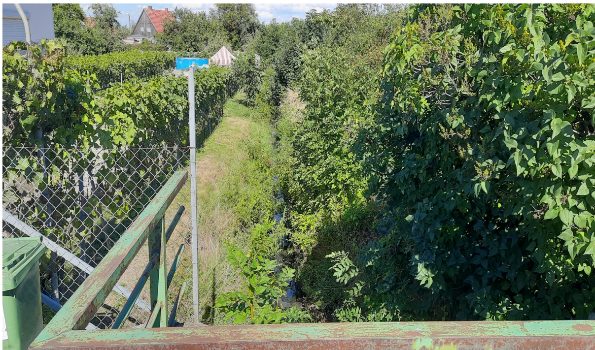
Fot.8. Widok rowu od strony ul. Woj. Polskiego
