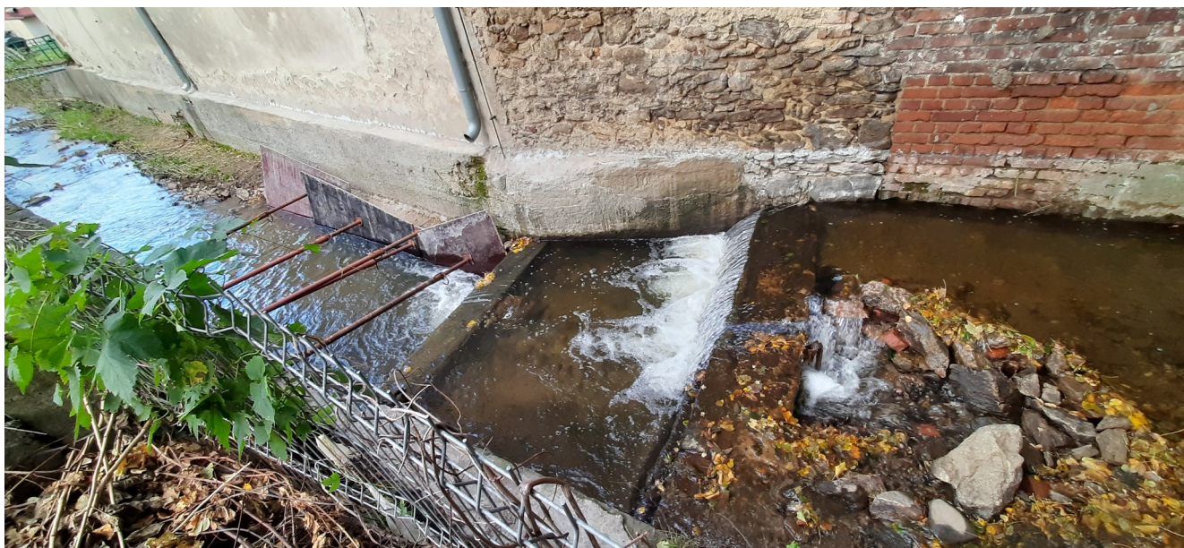
Fot.2. Tymczasowe zabezpieczenie muru koryta i fundamentu budynku
