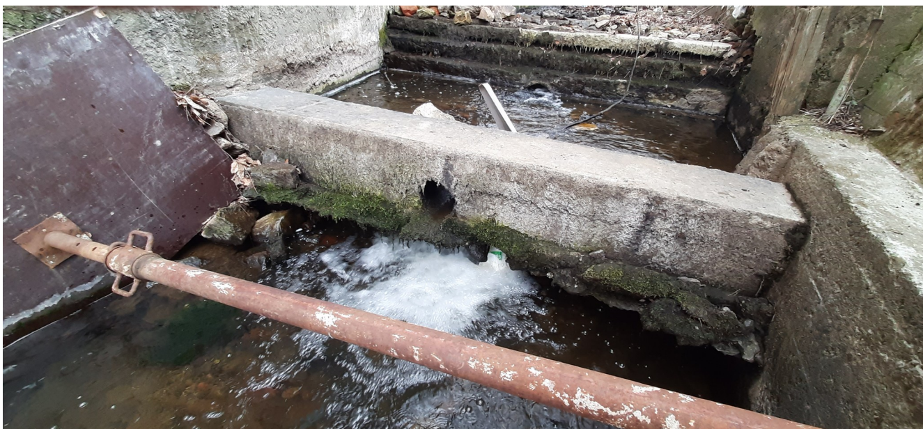
Fot.4. Próg betonowy
